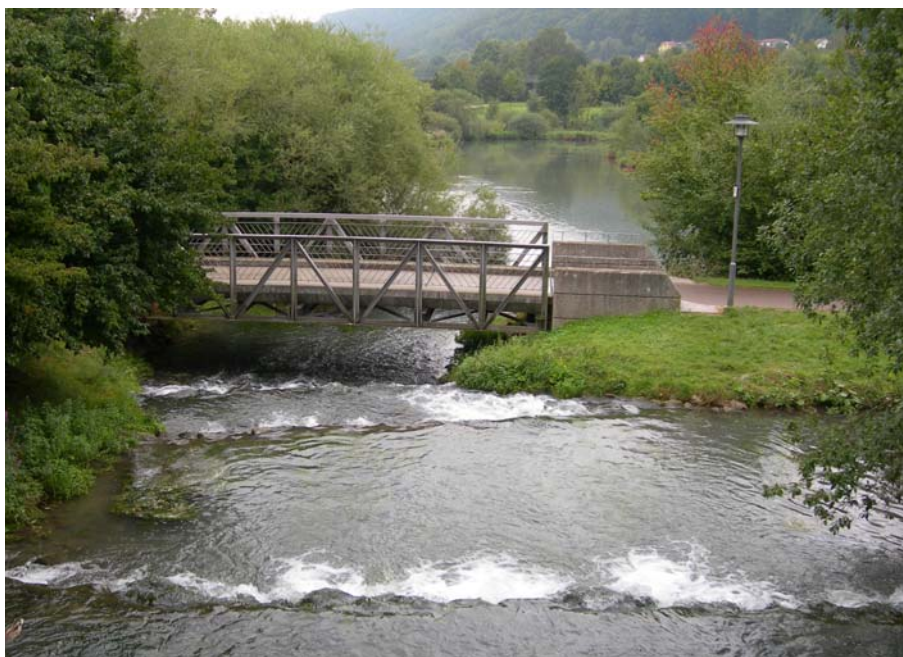
Abbildung 2.4: Fußgängerbrücke am Stadtweiher in Riedenburg
