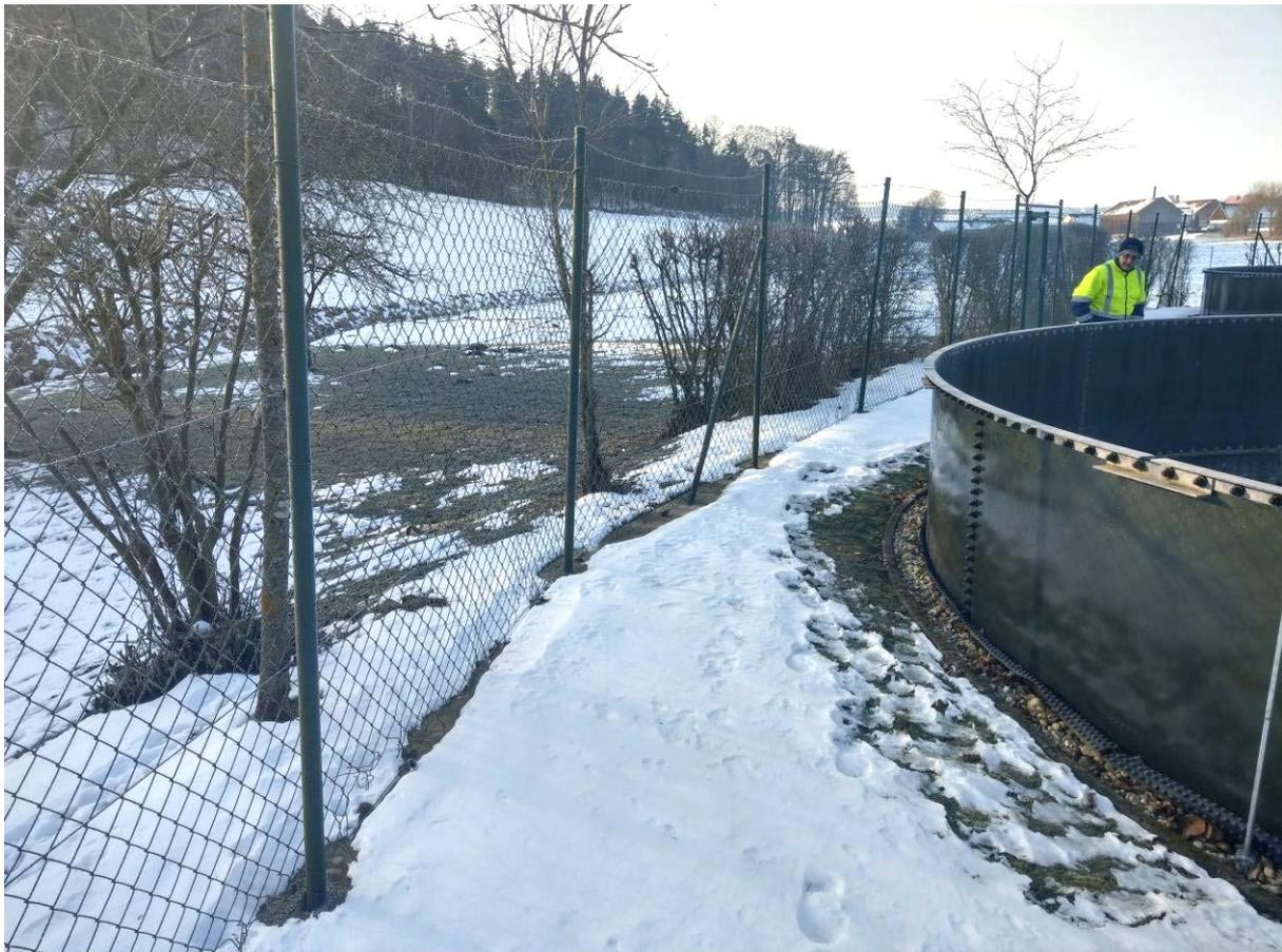
**Abbildung 4 - Möglicher Ort für einen Notüberlauf aus dem Ausgleichsbehälter**
