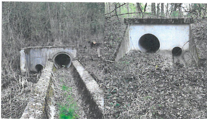
Abbildung 13: Auslaufbauwerk (RRB) in den Wolfsgrabenbach
